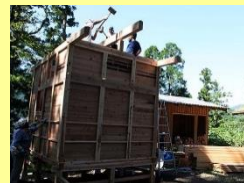
板倉建築の組み立体験
